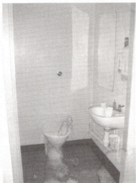
写真10 隔離室のトイレ
